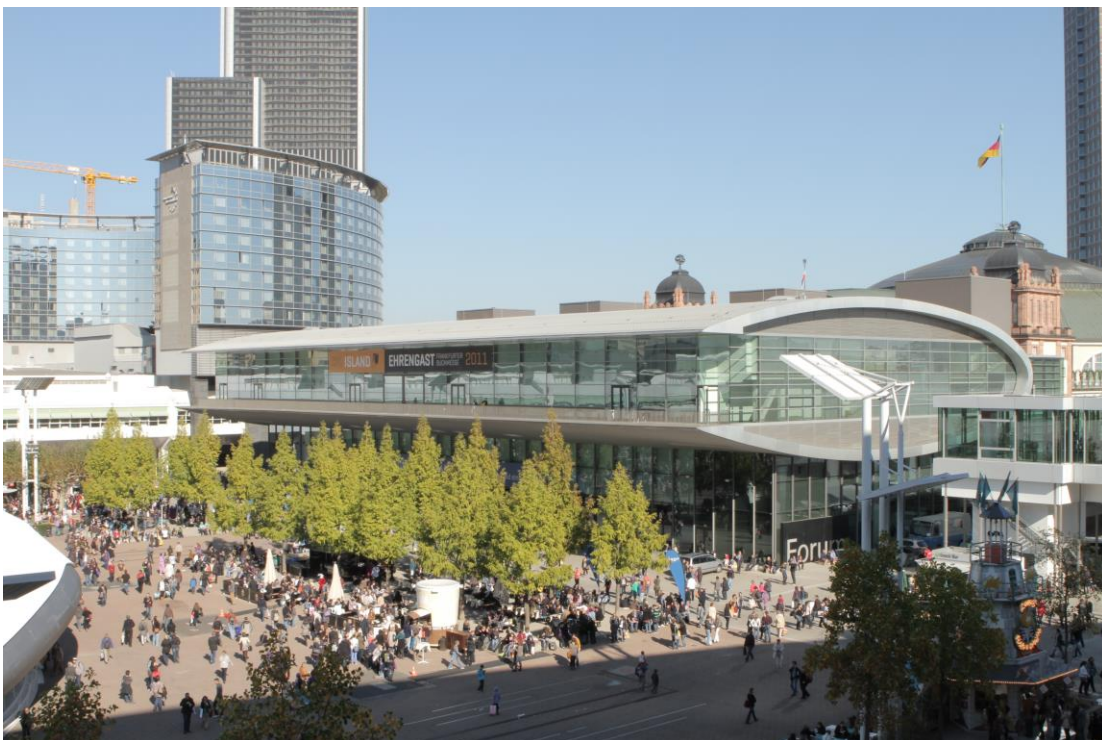
Hallen der paviljongen skal bygges, Forum.
